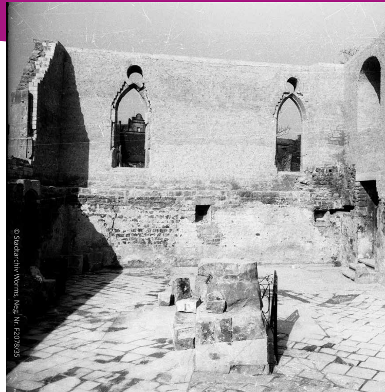
Die Westwand der zerstörten Synagoge während des Wiederaufbaus im März 1958.
